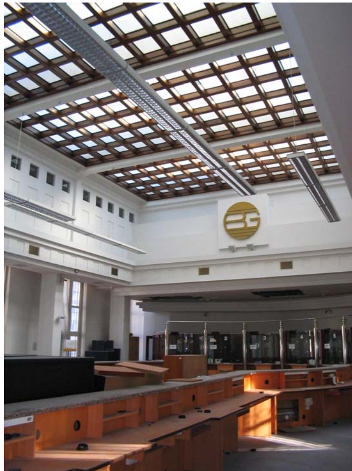
Długi Targ Main Hall to be refurbished
