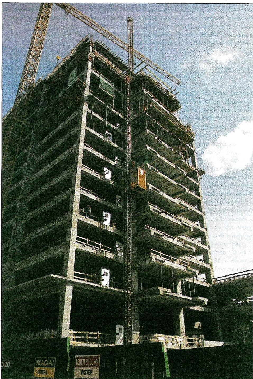
Budynek Andersia Tower będzie gotowy wiosną przyszłego roku
