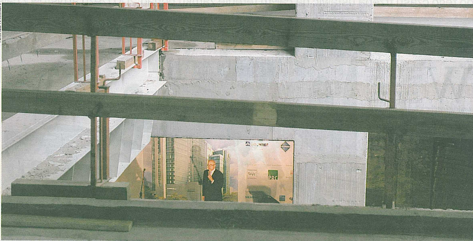
Adam Trybusz, dyrektor zarządzający Von der Heyden Group, przypomniał, że jego firma zamierza wybudować przy nowym wieżowcu jeszcze jeden – wysoki mieszkalny apartamentowiec
